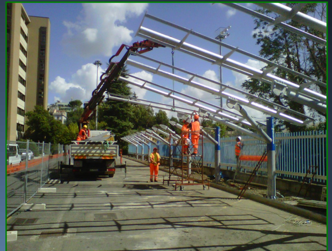
Ministero Infrastrutture e Trasporti - Montaggio strutture metalliche
